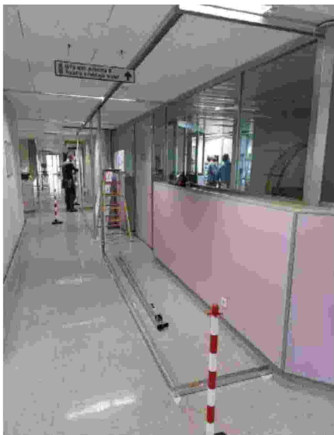
Ospedale | lavori di allestimento in pediatria
